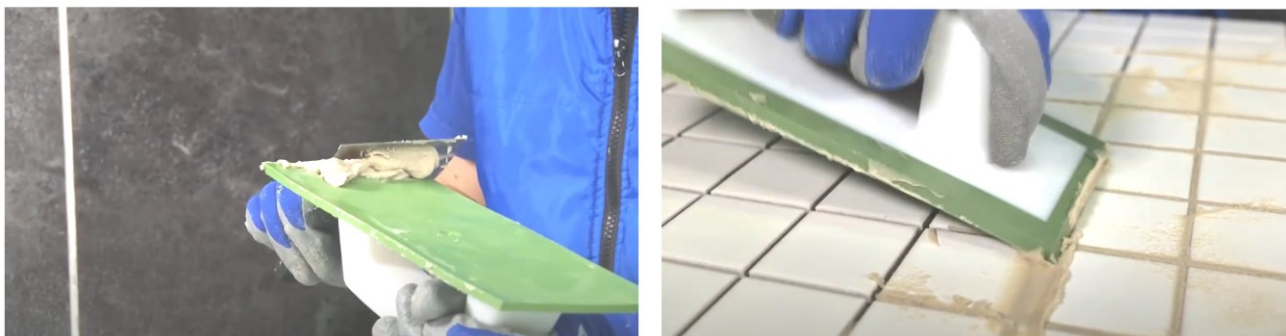
Рис. 3. Заполнение швов эпоксидной затиркой при помощи резинового шпателя
