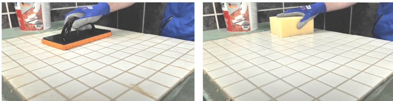
Рис. 5. Диагональными движениями шпателя убрать с поверхности плитки излишки затирки
